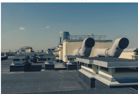
F5. 廠房 - 通風排氣
