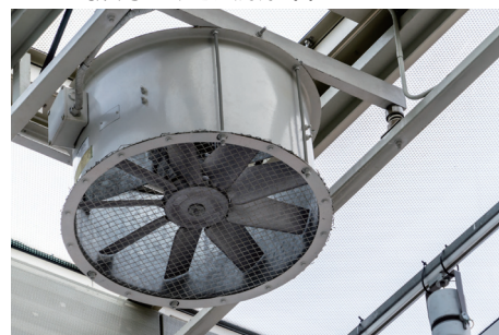
F6. 廠房 - 通風排氣
