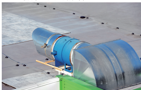
F4. 廠房 - 通風排氣
