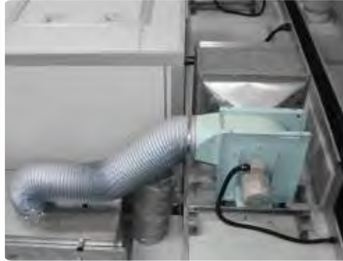
集塵過濾單機/系統運用
