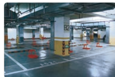
大樓/地下室/空調換氣
